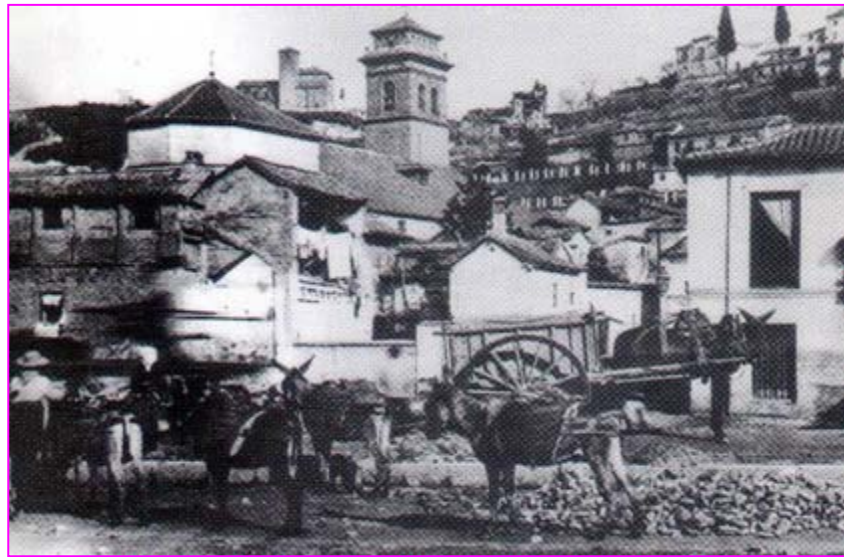
Fig. IV.8. Construcción de la Gran Vía.
